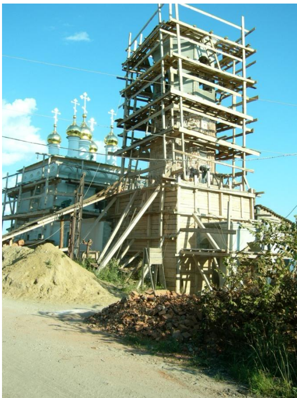
Фото 3. Внешняя опалубка для песчаной обоймы
