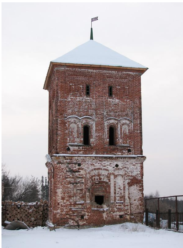
фото 10. Угловая башня монастыря Флорищева Пустынь после проведения работ (отклонение верха достигало 950 мм при высоте башни 16 м)
