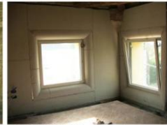
CAPPOTTO INTERNO CON RIFODERA IN CARTONGESSO
