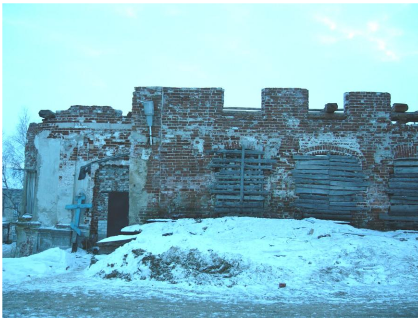
Фото 5. Состояние кирпичной кладки церкви Николая Чудотворца Никольского женского монастыря после разборки надстройки второго этажа. Фрагмент северного фасада.
