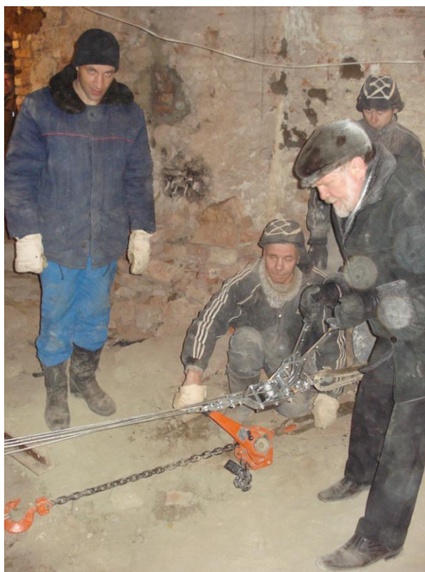
Фото 14. Устранение выпучивания западной стены келий Тихвинского Богородичного Успенского монастыря ручными таями.
