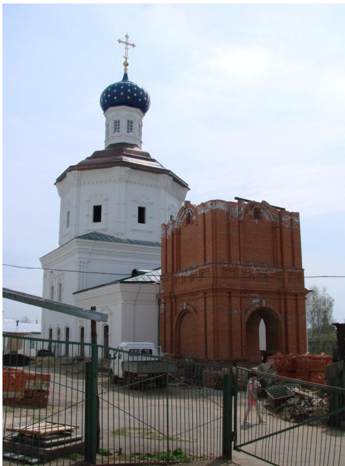
Фото 9. Церковь Николая Чудотворца Никольского женского монастыря после завершения основных работ по воссозданию строения. (2008 год).
