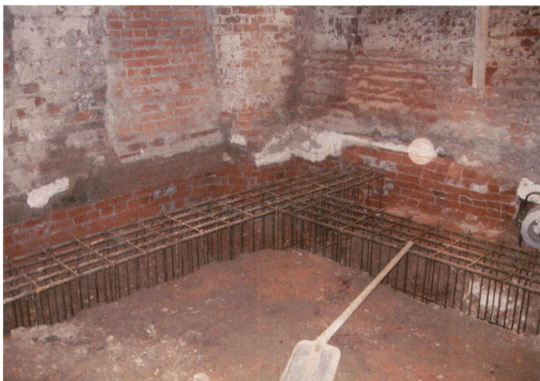
Фото 8. Армирование пристенных балок фундаментов трапезной церкви Николая Чудотворца Никольского женского монастыря.
