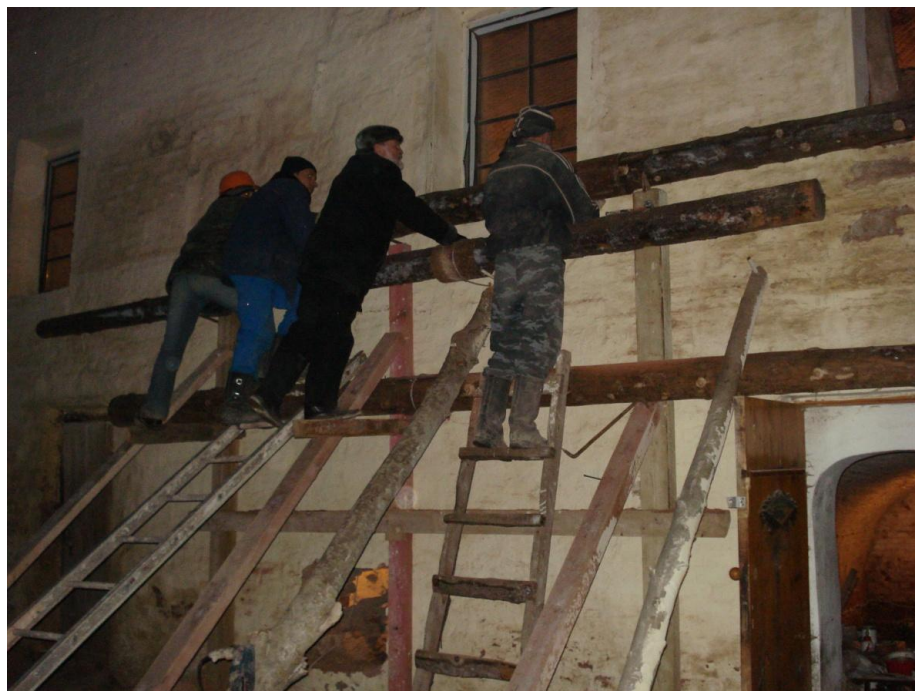
фото 13. Установка подкосов и бревенчатых анкеров к стене западного фасада келий Тихвинского Богородичного Успенского мужского монастыря.
