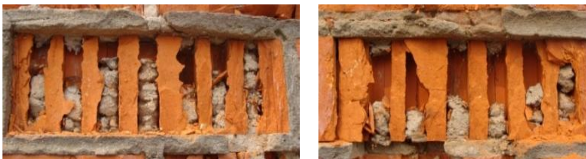
Рис. 2.1. Заполнение пор пустотелого кирпича кладочным раствором
