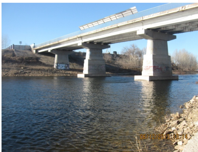
Рис. 1. Мост в г. Волжский, 48°48'23"с. ш., 44°43'05" в.д.
